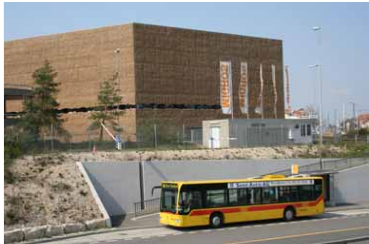
Die neue Haltestelle "Schaulager" der Linie 60 in Münchenstein ermöglicht ein rasches Umsteigen auf die Tramlinie 11.
