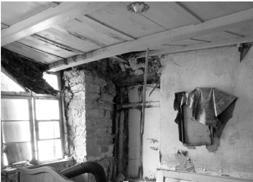
Neue Aussteifung mit Pfettenriegel und Windstreben Eingebrochene Balkendecke in der Erweiterung von 1885. Foto: Daniel Scheidegger, Kilchberg
