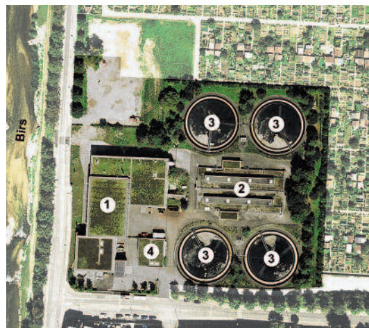
Abb. 1 Luftaufnahme alte ARA Birs 2. 1: Mechanische Vorreinigung, 2: Belebungsbecken mit Reinsauerstoffbegasung, 3: Nachklärbecken, 4: Betriebsgebäude.
