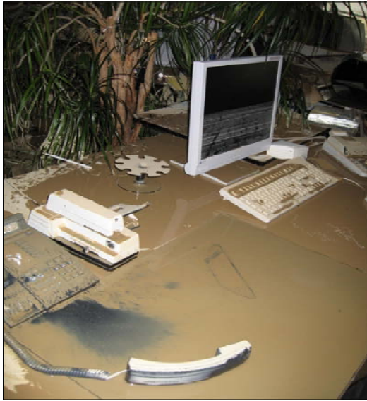
Situation in den Büros im Erdgeschoss
