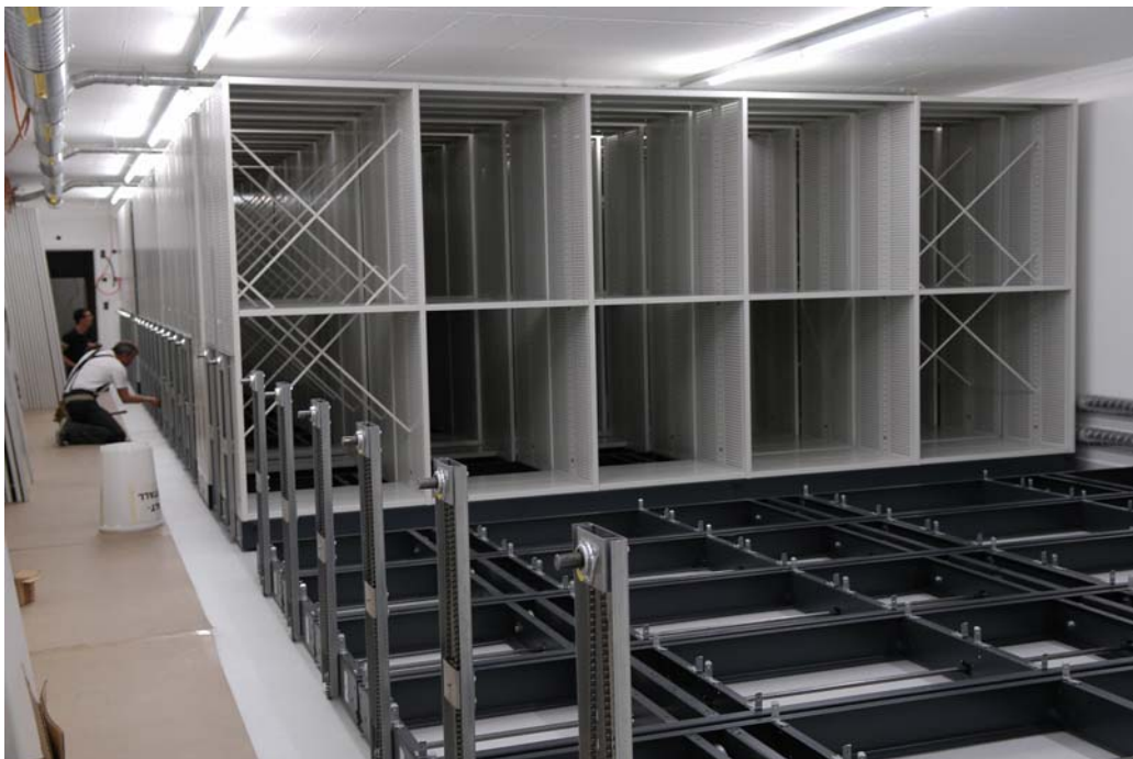
Bild 8 Bauarbeiten im Magazin
