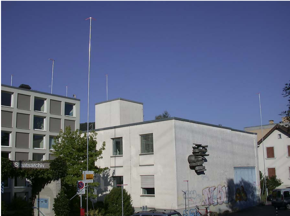
Bild 1 Altbau mit Profilen
