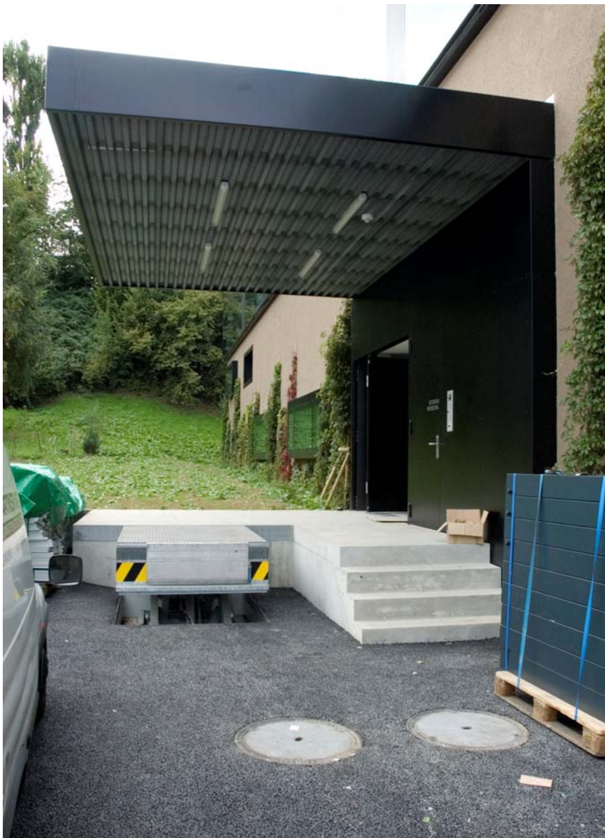
Bild 10 Seiteneingang mit Anlieferung
